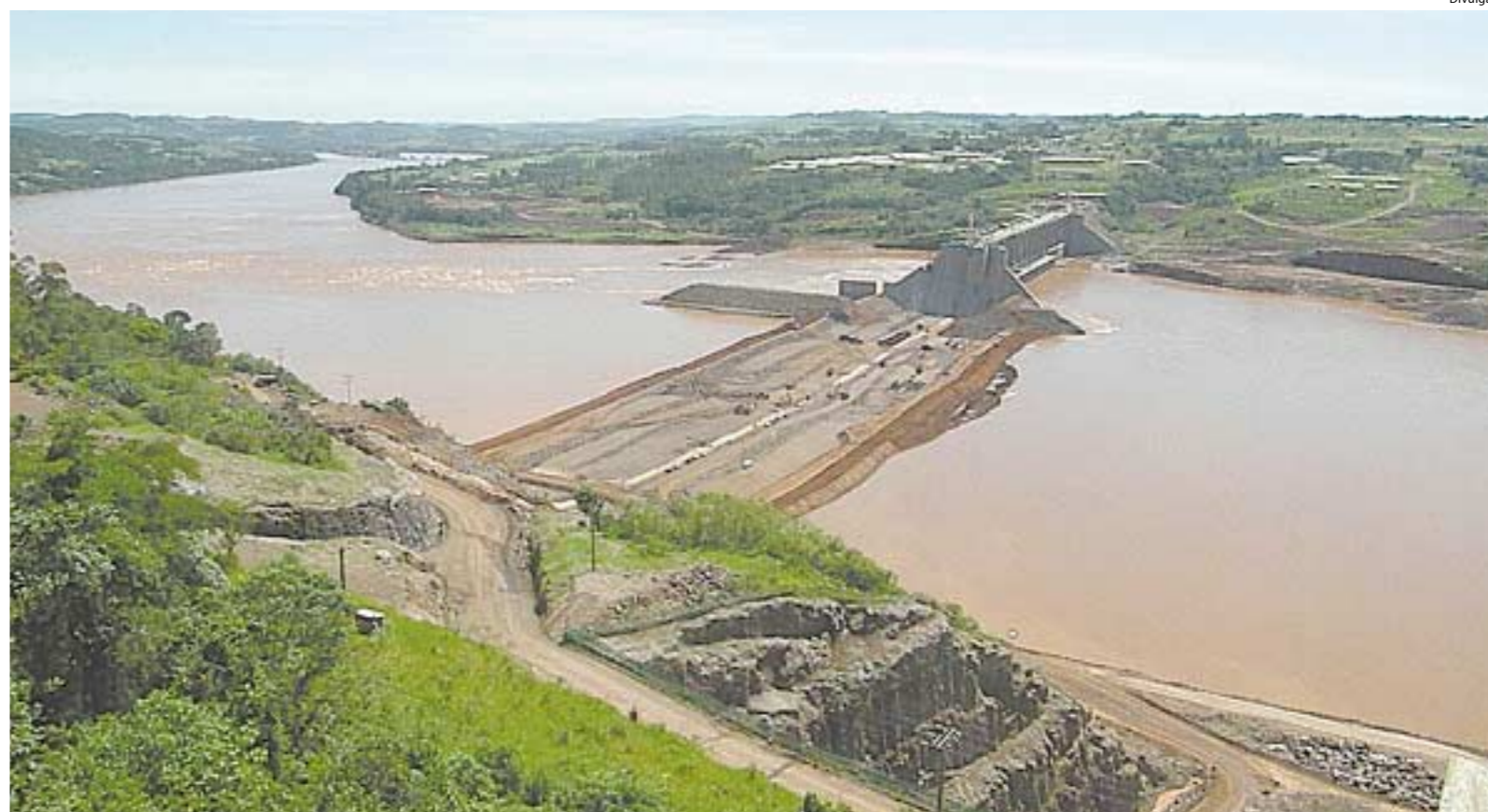
Imagem das obras da hidrelétrica, que está causando prejuízos financeiros para quem vive da pesca na região da Foz do Chapecó
