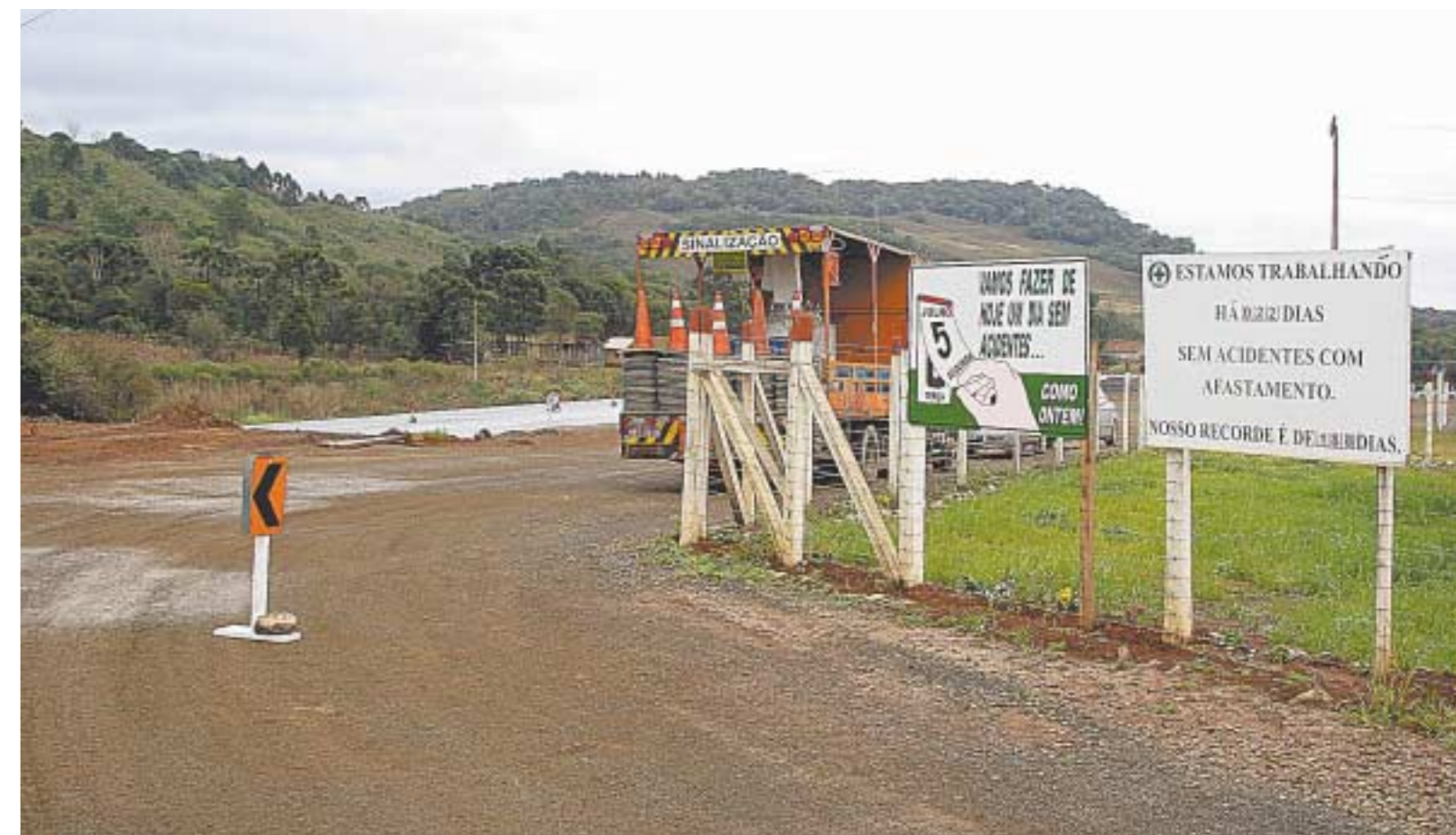
Na reta final dos trabalhos, 1,5 km ainda precisam receber Camada Porosa de Atrito e mais placas de sinalização
