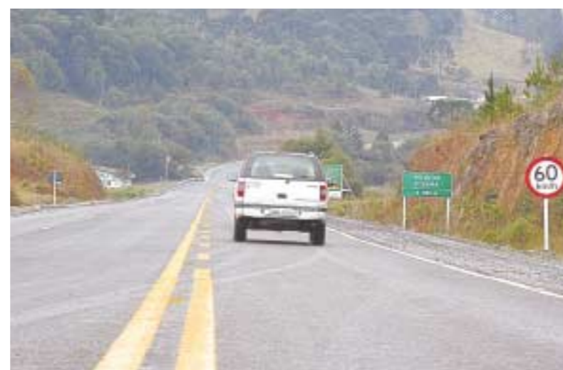
Orçada em R$ 100 milhões, obra trouxe segurança para motoristas
