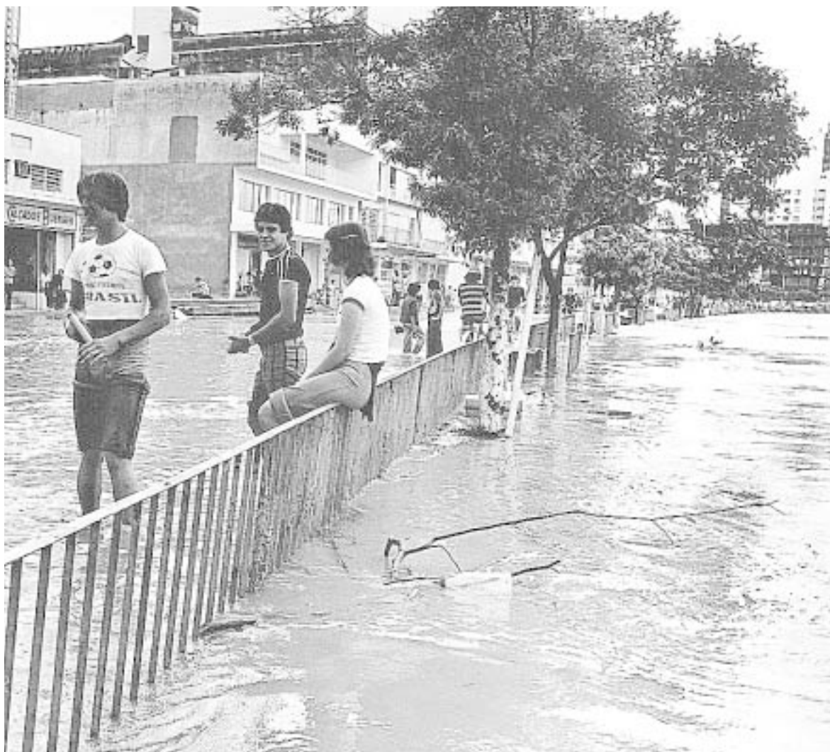
Rio Itajaí Açu invadindo Avenida Beira-Rio na enchente que deixou rastro de destruição em Blumenau, em 1983
