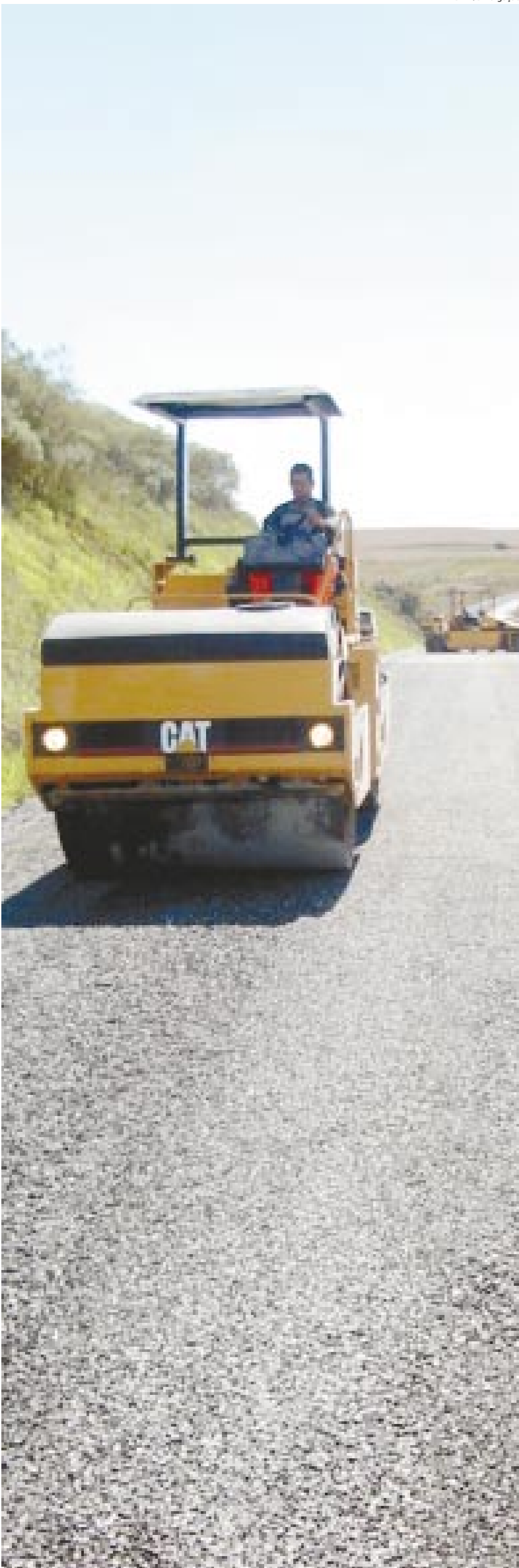
Vários trechos da BR-282 estão recebendo nova pavimentação, como este trecho de São José do Cerrito, no Planalto Serrano
