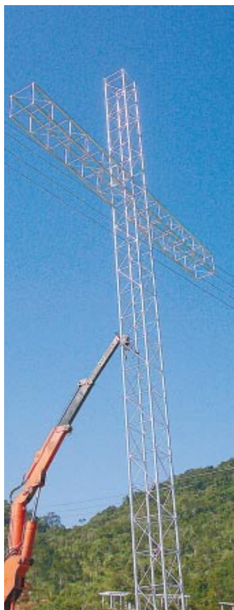
Cruz em estrutura metálica foi recuperada
