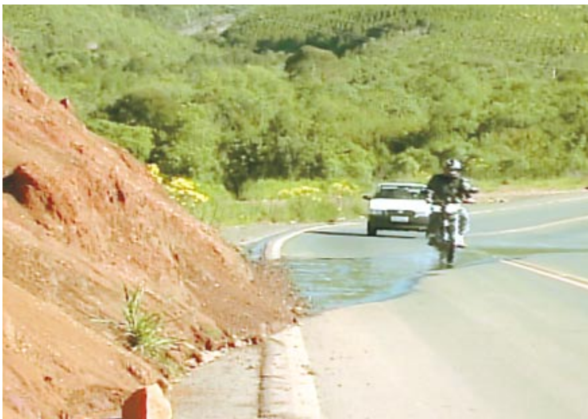
... está há mais de um ano com o acostamento coberto por terra decorrente de deslizamento
