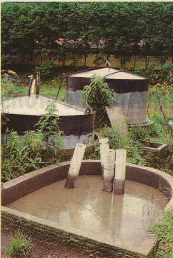
Biodigestor da propriedade de Sadi Zago
