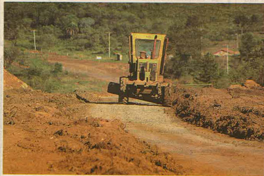
Obras só andam no trecho onde o Batalhão está trabalhando
