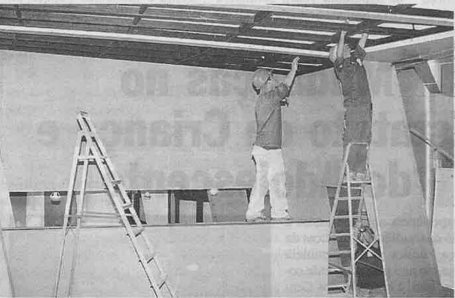
Obras devem demorar cerca de dois meses
