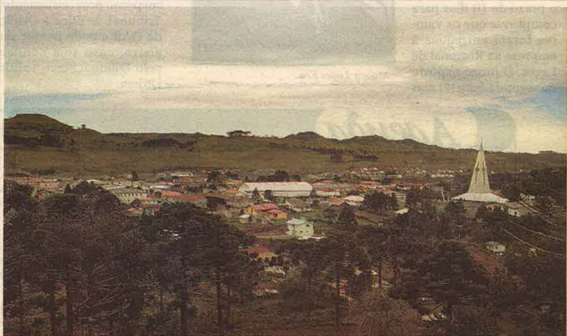
Os 4.500 habitantes de Bom Jardim da Serra já são abastecidos pelo gerador eólico
