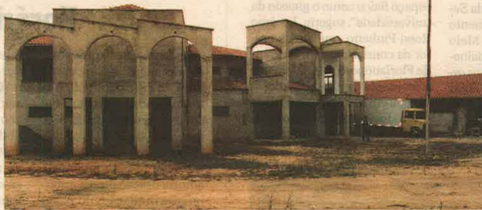
Obras do novo hospital da cidade
