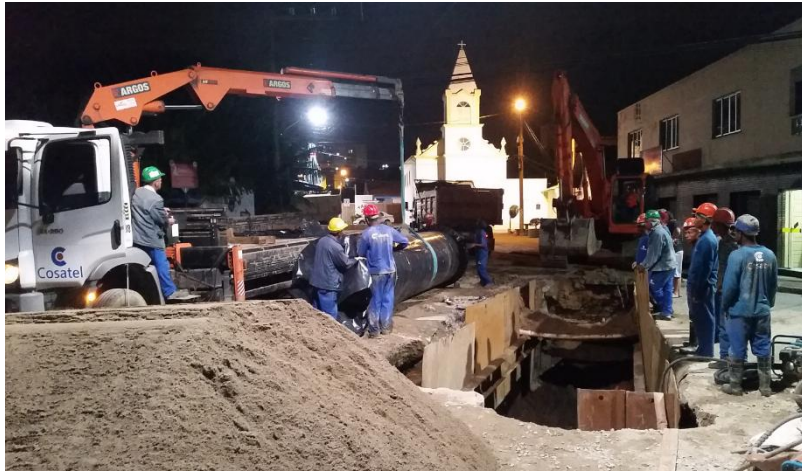
ADUTORA DN1200 (TRECHO 3)
